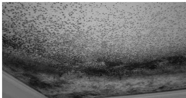
Фото 5. Вид потолка, поражённого грибами-деструкторами с обильным спороношением, в элитном доме
